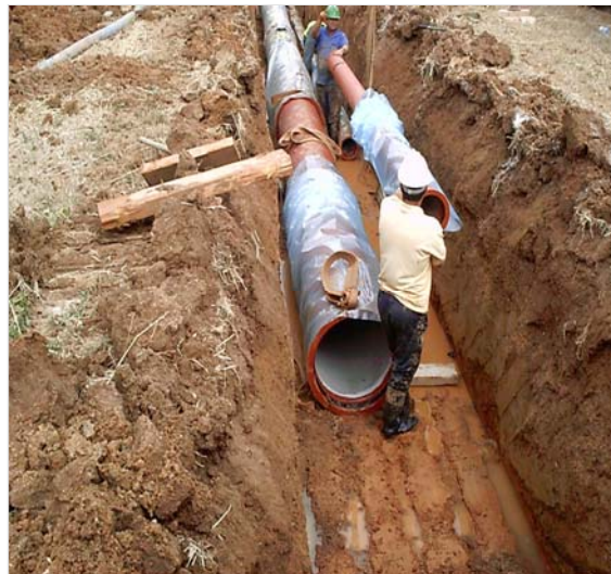
Instalación de colector
